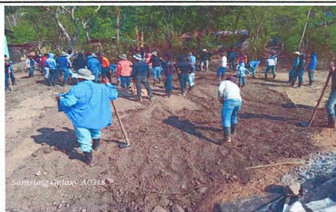
Foto 2: Mejoramiento de dos aulas Tipo Pórtico.
