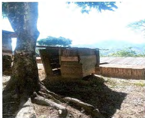
Foto 3: Mejoramiento de Servicio Sanitario.
