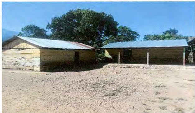
Foto 1: Mejoramiento de dos Aulas tipo Pórtico.
