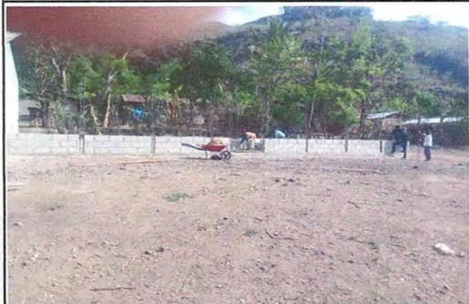
Foto 3: Mejoramiento de dos aulas Tipo Pórtico.
