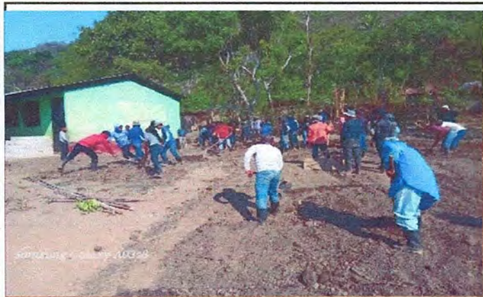
Foto 1: Mejoramiento de dos aulas Tipo Pórtico.
