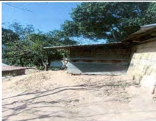
Foto 2: Mejoramiento de Cocina.
